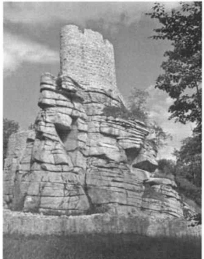
Matratzenlager – Schalige Absonderungsklüfte („Lagerklüfte“) an der Ruine Weißenstein.
