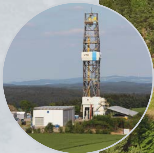
Blick in die Tiefe – Kontinentale Tiefbohrung KTB.
