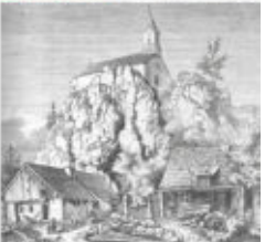
☐ Historische Ansicht des Rosenquarzfelsens von Pleystein von Carl Wilhelm Giesel (1876). Monumentalgebäude der römisch-katholischen Kirche in Pleystein (unter Carl Wilhelm Giesel). 1876.
